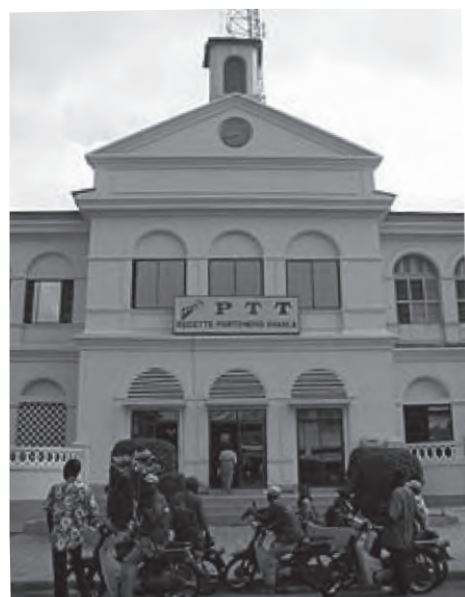
III. 7 : l'entrée de la Poste ayant retrouvé son aspect originel.
