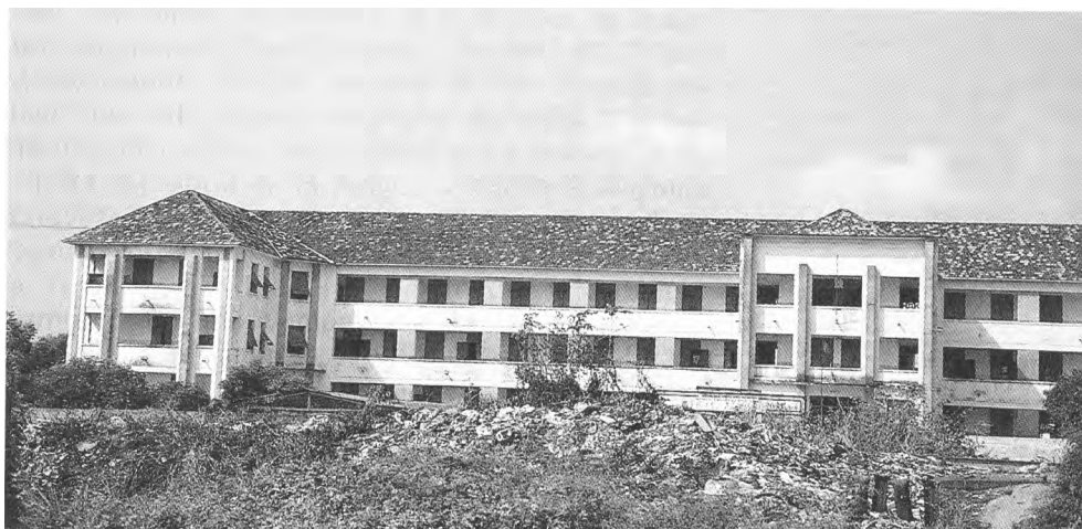
III. 41 : lycée Béhanzin, construit dans les années 1950.
